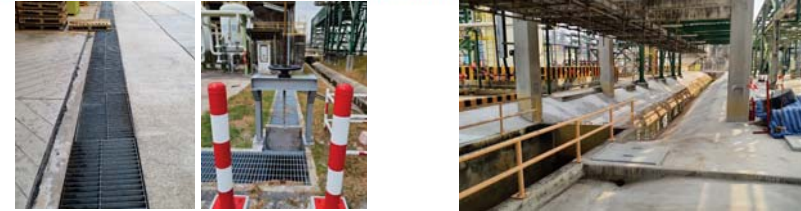
รางระบายน้ำจากกระบวนการผลิตเข้าสู่ระบบบำบัด
